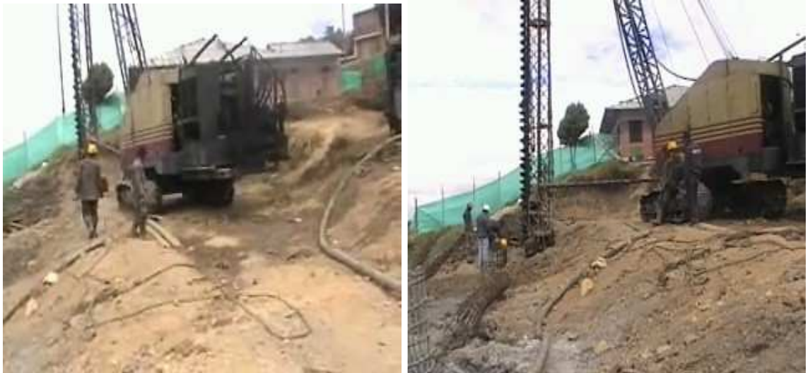
Sector donde se ubicarán los pilotes
