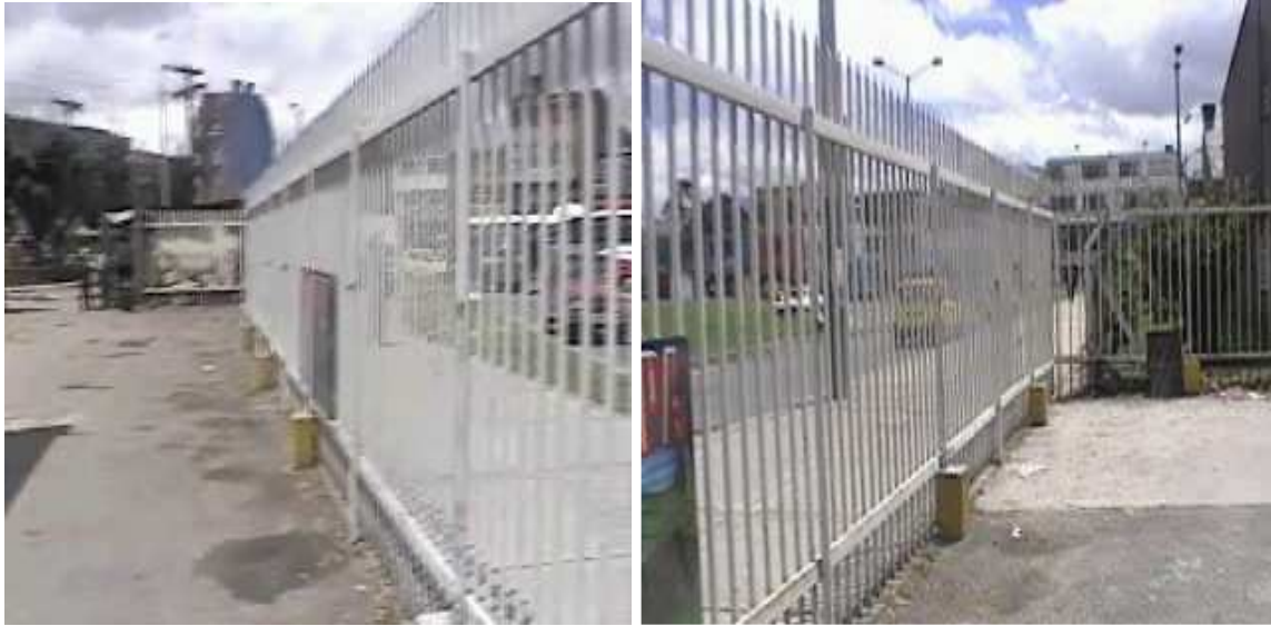
Cerramiento del predio perteneciente al Distrito, con reja metálica de 2.1 metros de altura.
