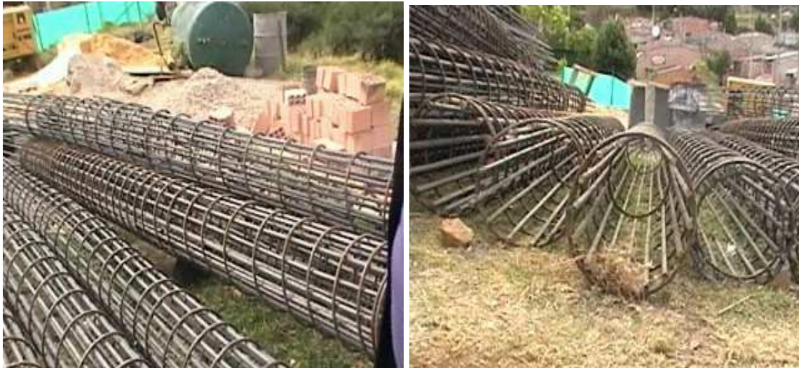
Estructura metálica de los pilotes.
