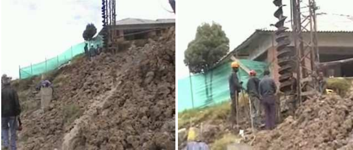
Maquinaria necesaria para excavación del volumen para ubicación de los pilotes.
