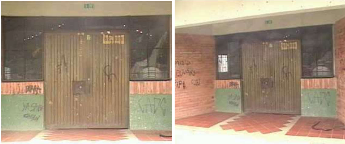
En la puerta de acceso al salón comunal se observa el aviso de sellamiento. Se constató que a la fecha de la visita el salón comunal se encontraba en uso.
