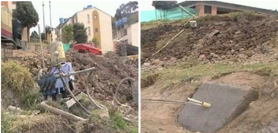
Área de trabajo y tensores ubicados en la parte sur del parqueadero.
