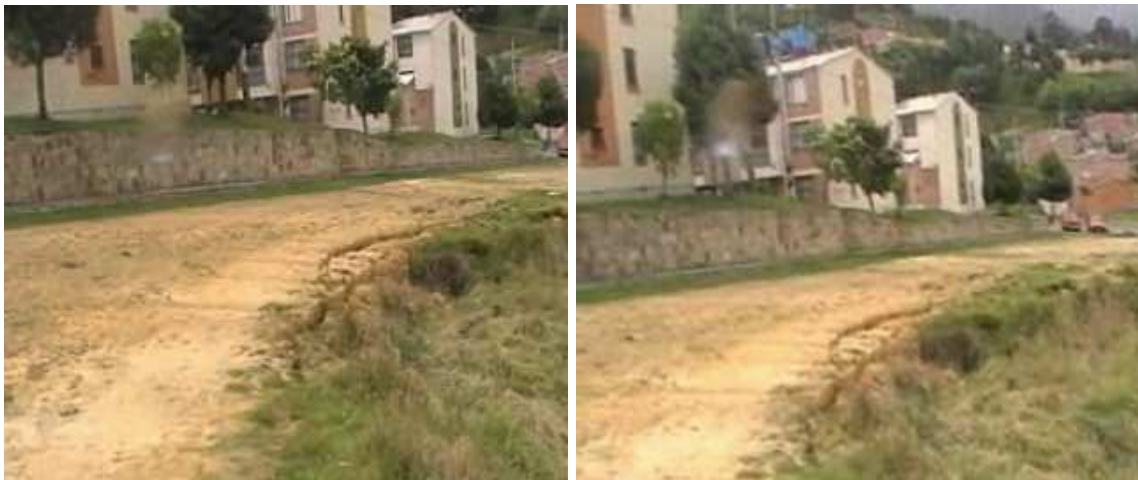
En el parqueadero del sector sur se observa amenaza de remoción en masa según diagnóstico de la DPAE – Dirección de Prevención y Atención de Desastres.
